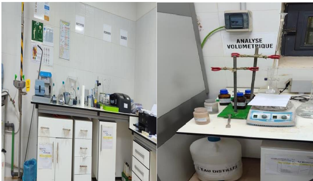
Figure 9 : Laboratoire de la station de dessalement.
