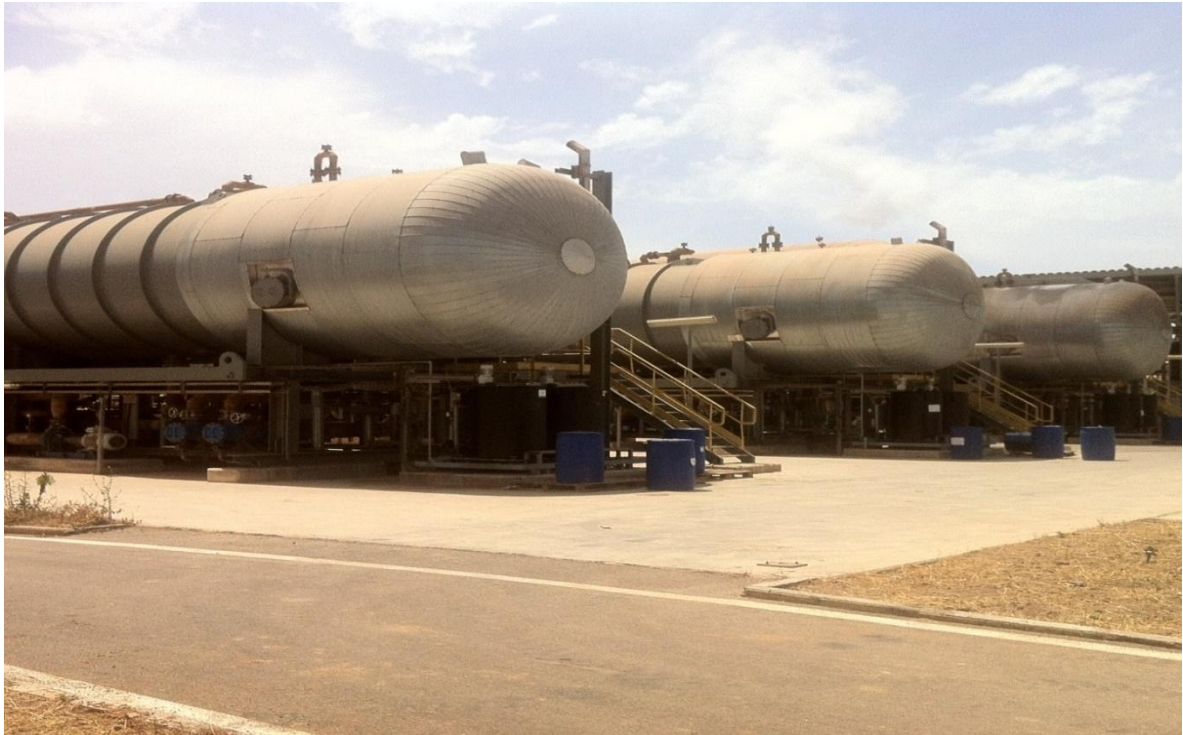
Figure I.3 : L'unité du procédé de dessalement à thermo-compression
