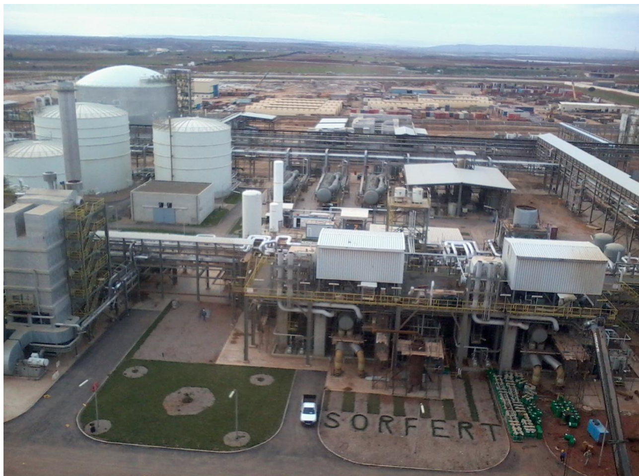
Figure I.2 : Vue du haut de la zone des utilités
