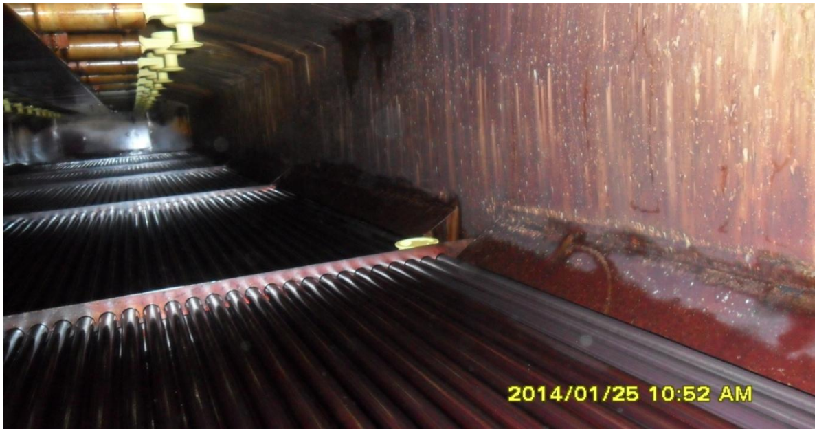
Figure II.4.2 : La cellule d'évaporation de l'unité de dessalement U .510
