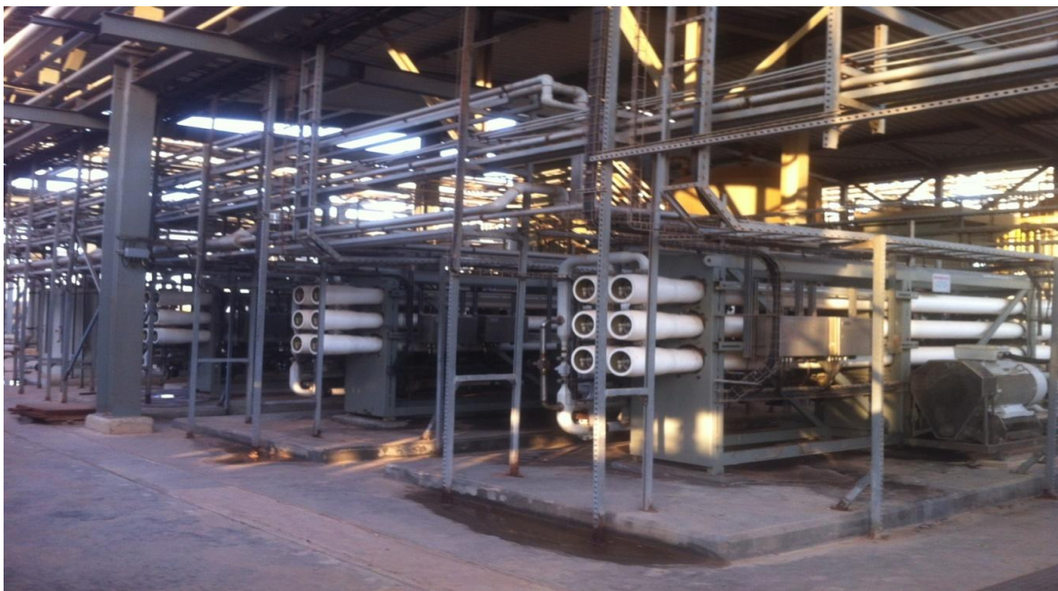
Figure I.4 : L'unité du procédé de dessalement à osmose inverse
