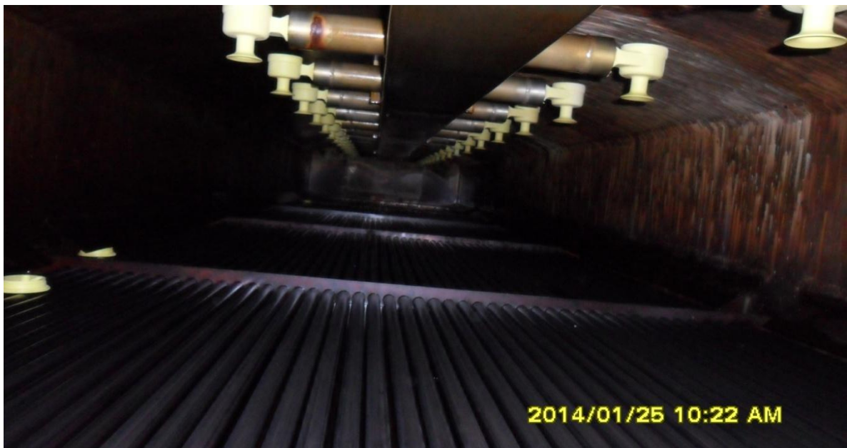
Figure II.4.1 : La cellule d'évaporation de l'unité de dessalement U .510
