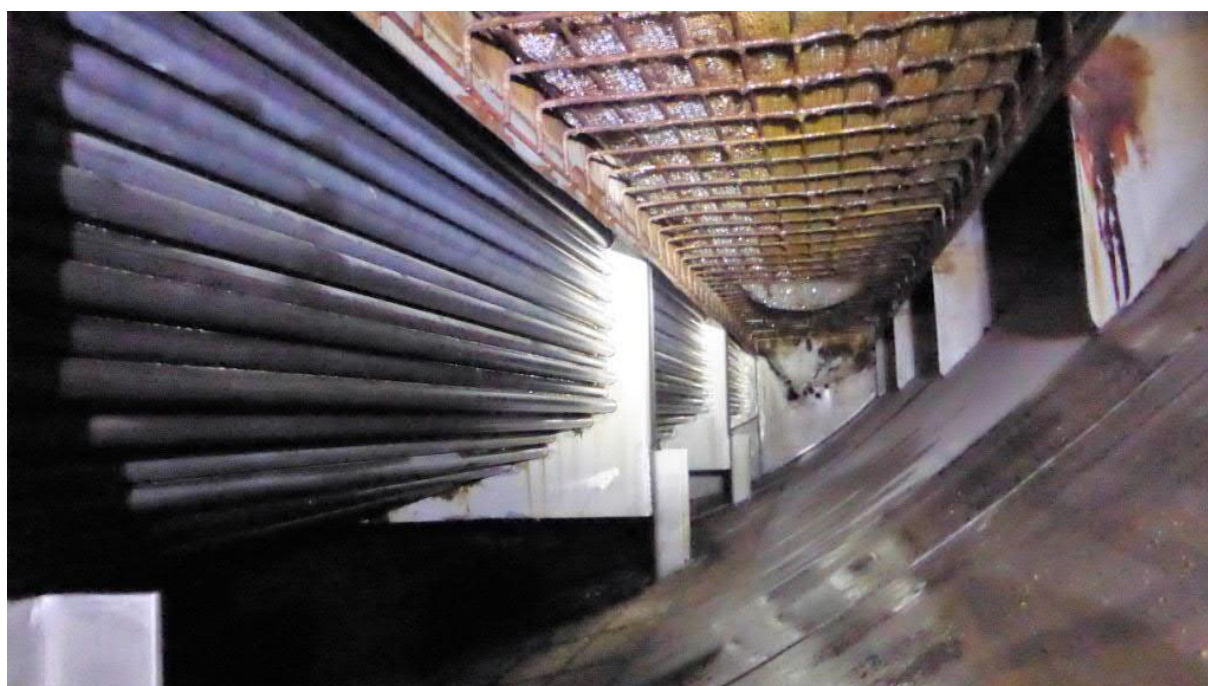
Figure 31 : l'U510 après nettoyage chimique
