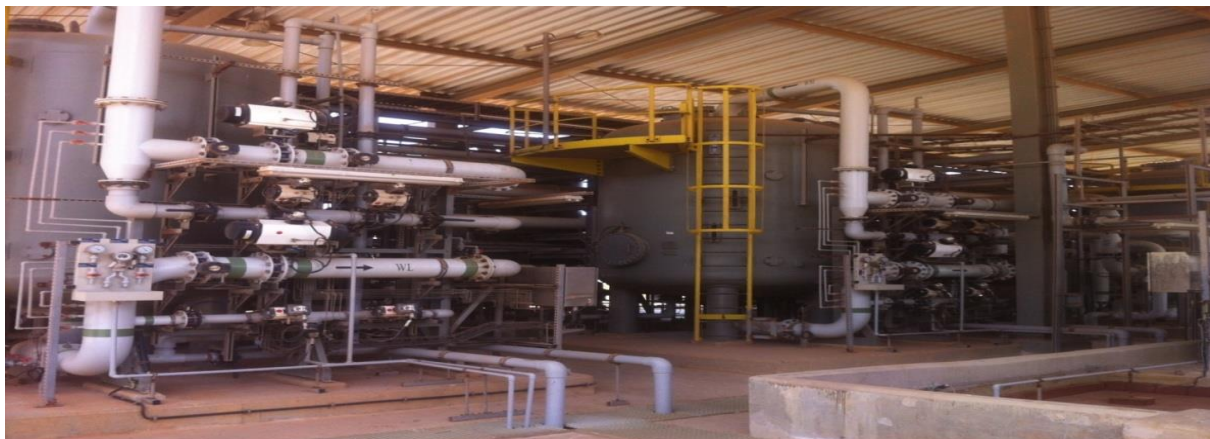
Figure 9 : L'unité de déminéralisation et de polissage
