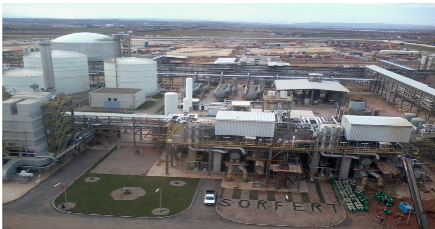
Figure 5 : Vue du haut de la zone des utilités
