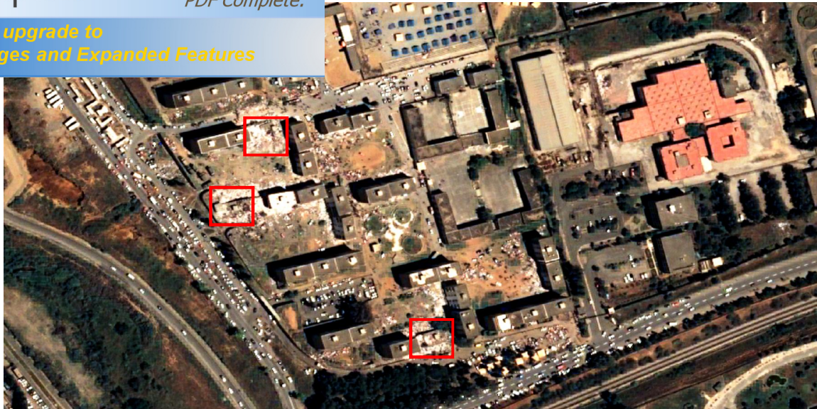
Figure 5.3 du 23 Mai 2003 représentant une zone urbaine de la wilaya de boumerdess après séisme (source sertit)
