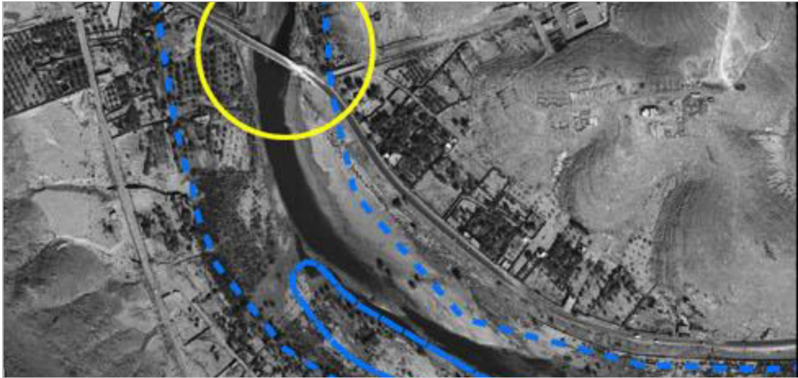
Figure 5.2.8 zoom dans le figure 5.2.1 inondation de Ghardaïa (source sertit)
