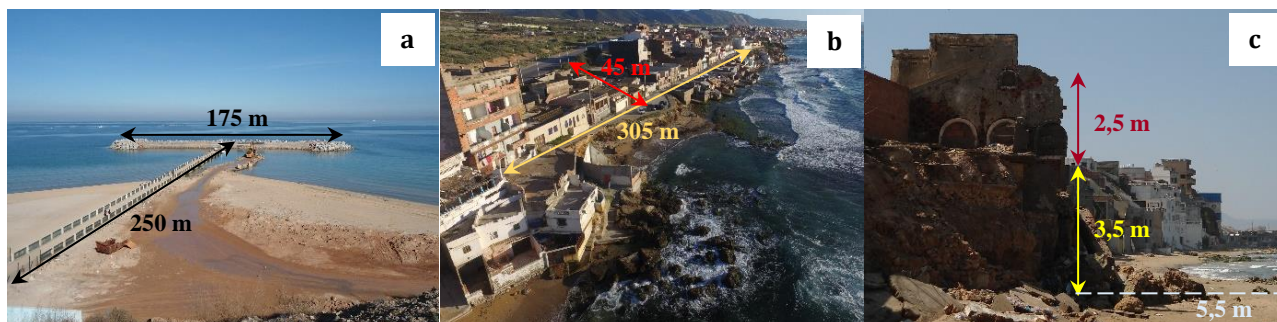
Figure 47 : Impacts anthropiques sur le littoral dunaire de Bousfer et Ain el Turck, a. Quai d'accostage et brise-lame, b - c. Erosion accélérée et sapement des constructions par les vagues. (Cliché 2019 : a et c : Bougherira A., b : Association SAHEL)
