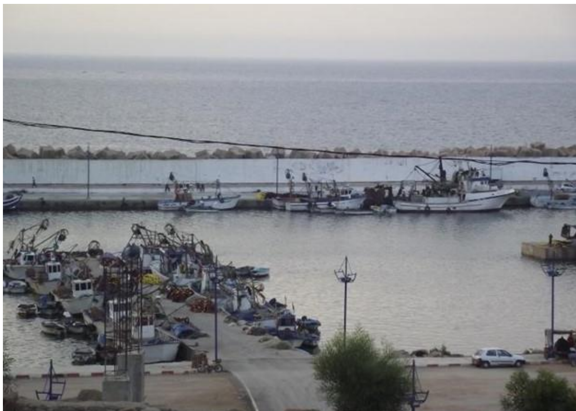
Figure I.7. Port de Sidi Lakhdar (petit port)
