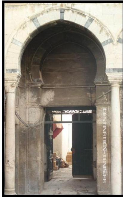
Figure 133 El Ali avant la restauration
