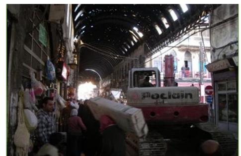
Le souk Medhat Bacha pendant la réhabilitation
