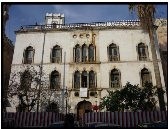
Figure 190 : La façade construite dans la période française palais Hassan pacha
