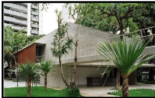
Figure 167 Le nouveau bloc
