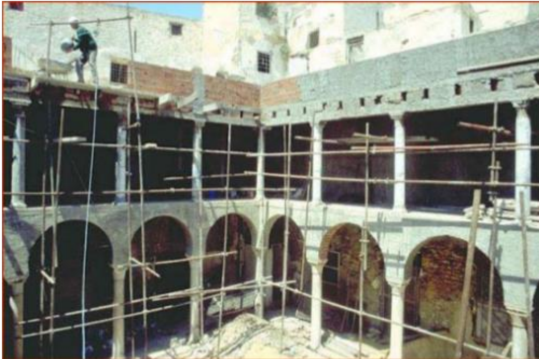
Fig.39 :La réhabilitation d'un oukala
