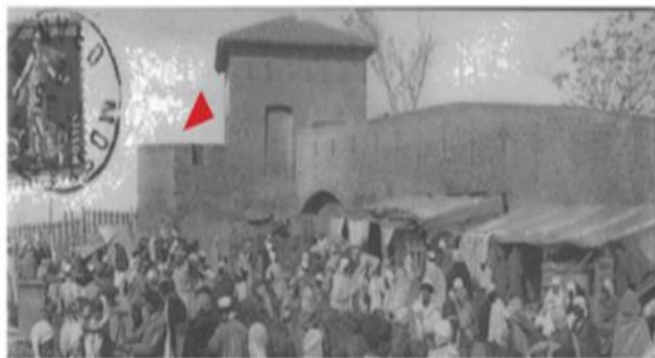
P1 : Une partie de la porte du Fort de l'Est
