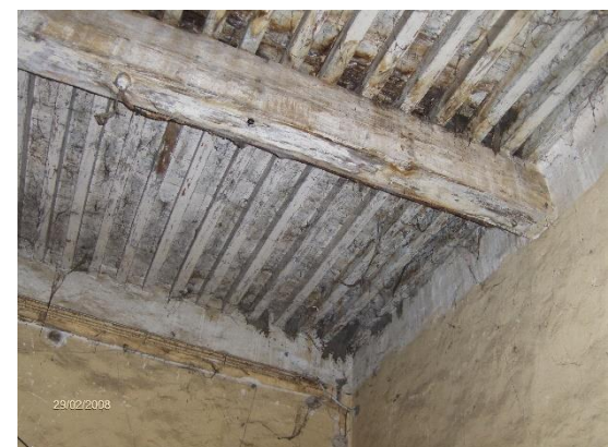
plancher en bois poutres et solives recouvert D'une couche de terre
