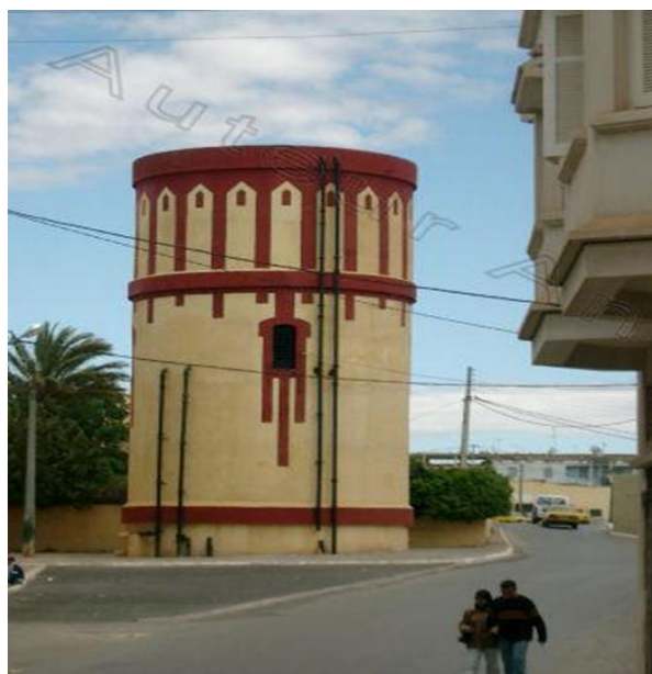
Façade du château d'eau
