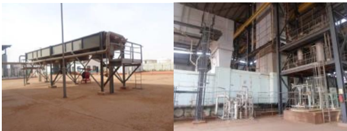
Figure 7: poste à gaz et les aéro d'huile
