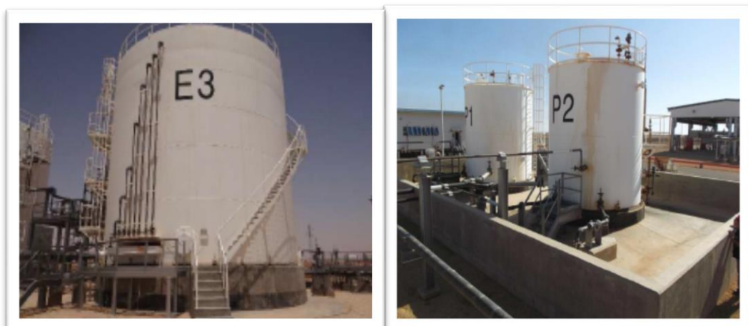
Figure 6: Centre de traitement des eaux
