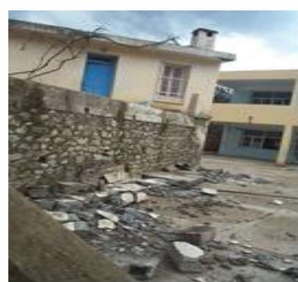
Figure 28. Séisme de Kherratta, Bejaia (Algérie) en 2006 : Bâtiments scolaires endommagés
