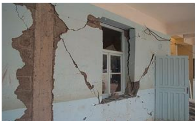
Figure 27. Nouvelle école en phase de construction endommagée suite au séisme de Boumerdes (Algérie) de 2003.
