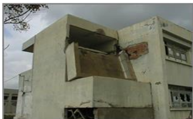
Figure 25. Séisme d'Aïn Témouchent (Algérie) en 1999 : Bâtiments scolaires endommagés.
