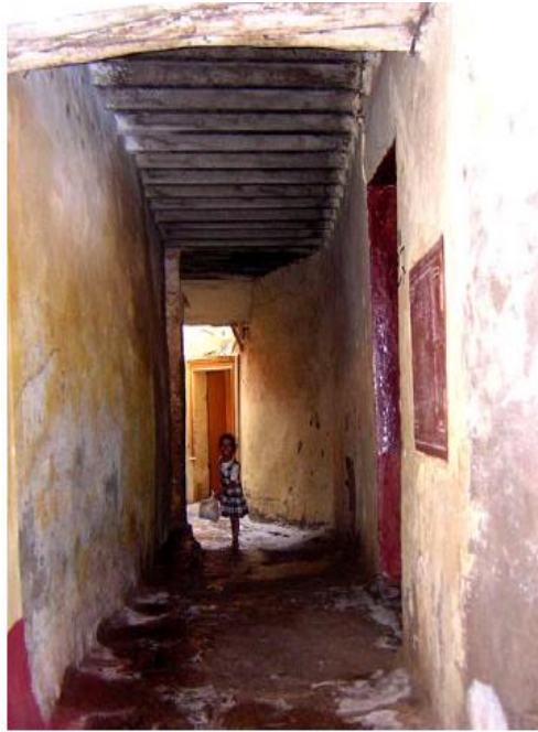
Figure 11. Exemple d'une ruelle à quartier Tobana (Moulay Belhamissi, 1976).
