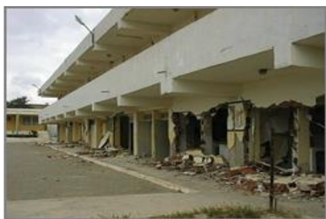
Figure 24. Les bâtiments scolaires endommagés suite aux séismes de Beni Chougran à Mascara (Algérie) en 1994.
