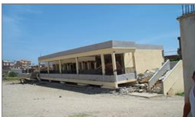
Figure 25. Séisme d'Aïn Témouchent (Algérie) en 1999 : Bâtiments scolaires endommagés.
