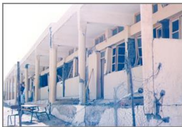
Figure 24. Les bâtiments scolaires endommagés suite aux séismes de Beni Chougran à Mascara (Algérie) en 1994.
