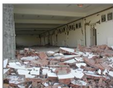
Figure 27. Nouvelle école en phase de construction endommagée suite au séisme de Boumerdes (Algérie) de 2003.
