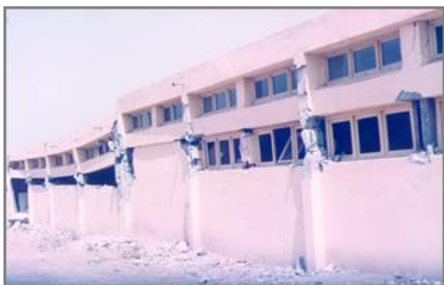
Figure 24. Les bâtiments scolaires endommagés suite aux séismes de Beni Chougran à Mascara (Algérie) en 1994.
