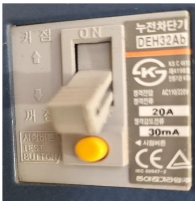
Figure 3.7 : a) Disjoncteur principal différentiel
