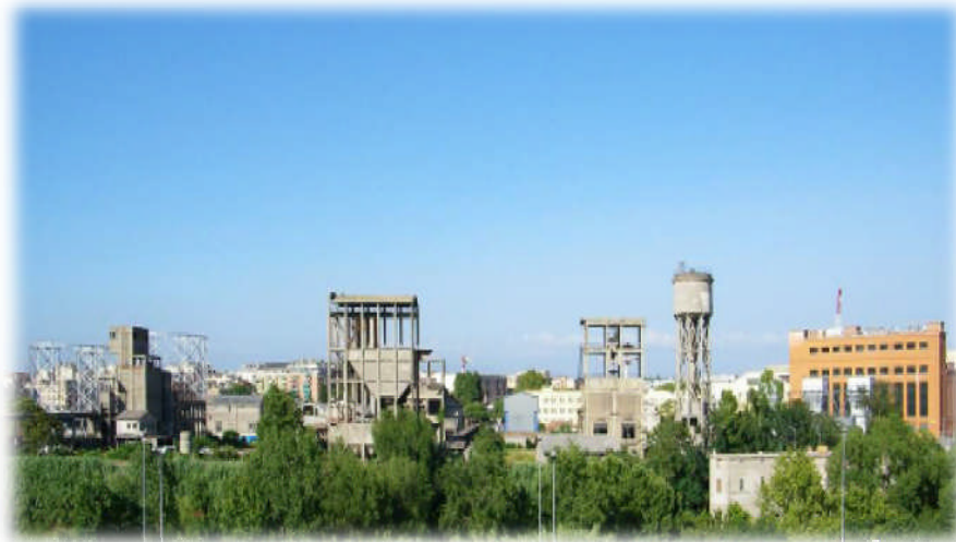
Figure 5 : Les bords du Tibre vus de la rive droite. À gauche les vestiges de l'usine à gaz ; à droite la centrale Montemartini. Phot. Buffa, Géraud, 2011
