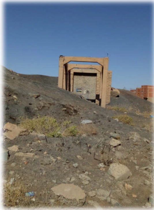
Figure 59 : Entrée d'une descenterie de tunnels, auteur, décembre 2017
