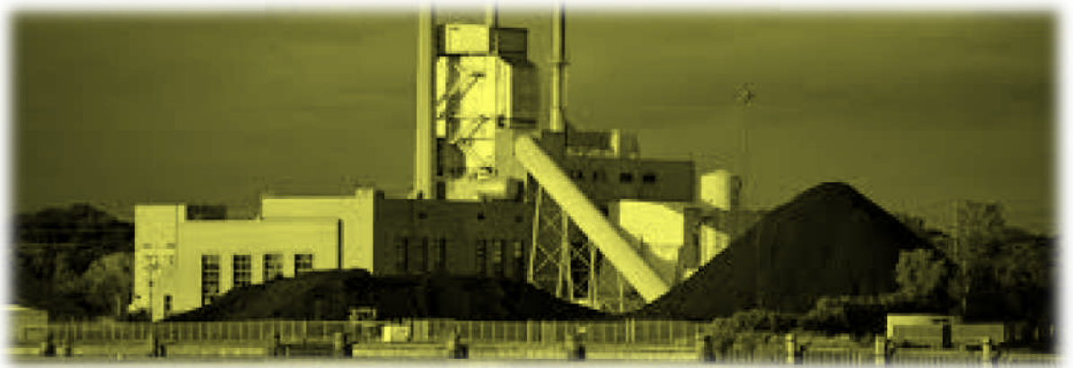
Figure 2 : Une des centrales à charbon allemandes, en arrêt d'activités, 1976.
