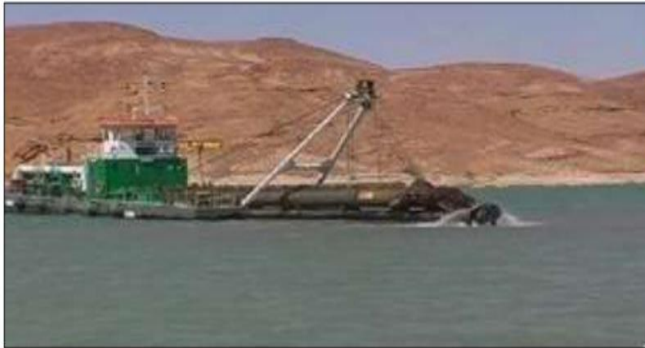
Figure II.14 : Dragage activant dans la retenue du barrage Foug-El-Gherza (Biskra) [57].
