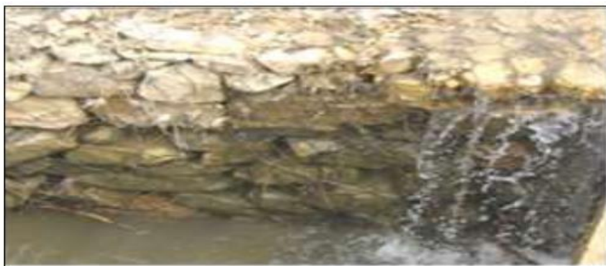
Figure II.8: Seuil de sédimentation en gabions et en pierres sèches [54].
