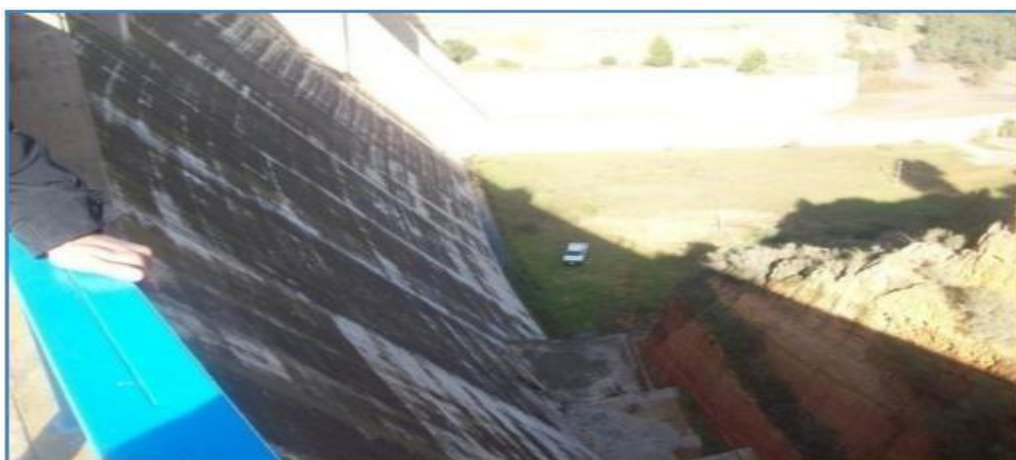
Figure II.21 : Vue du côté interne de la digue du barrage Chorfa
