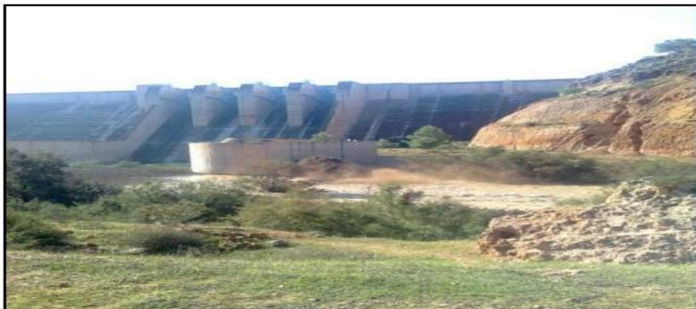
Figure II.19 : Vue générale du barrage de Chorfa
