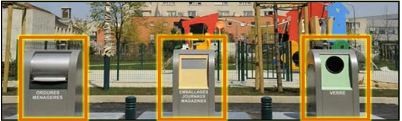
Figure49: les bornes enterrées
