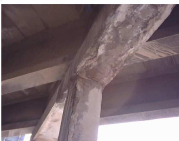
Fig. II.12 : Oxydation générale du chevêtre Pont Passiti (Oran)
