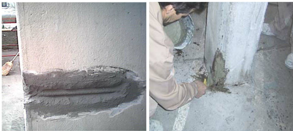
Fig. IV. 9 : Réparation Du Béton
