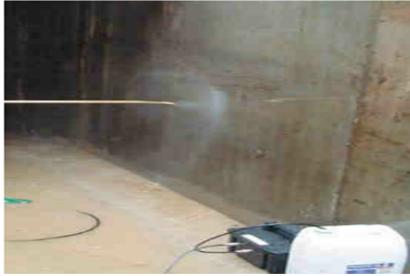
Fig. IV.11 : Mise en place d'un revêtement de surface
