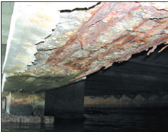
Fig. II.11 : Corrosion importante en sous face d'une poutre pont Port de Mostaganem.
