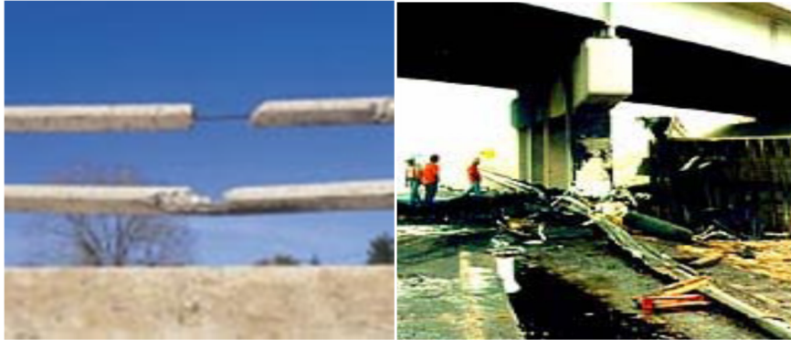
Fig. II.18:Choc sur une glissière de sécurité et une pile de pont
