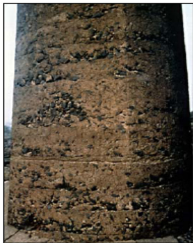
Fig. II.16: Abrasion du béton
