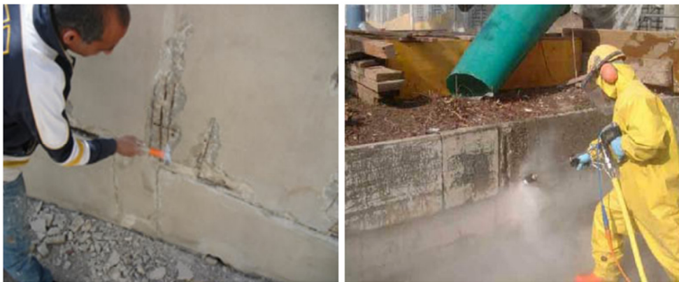
Fig. IV. 7 : Technique De Réparation (carbonatation)
