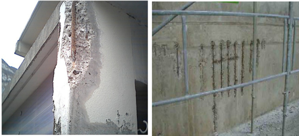
Fig. IV. 8 : Traitement Des Armatures
