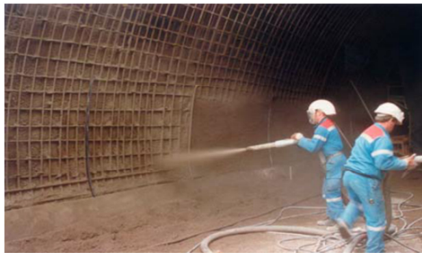
Fig. IV. 3 : Projection de béton
