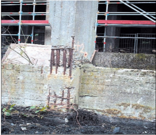
Fig. II.9 : Corrosion par carbonatation
