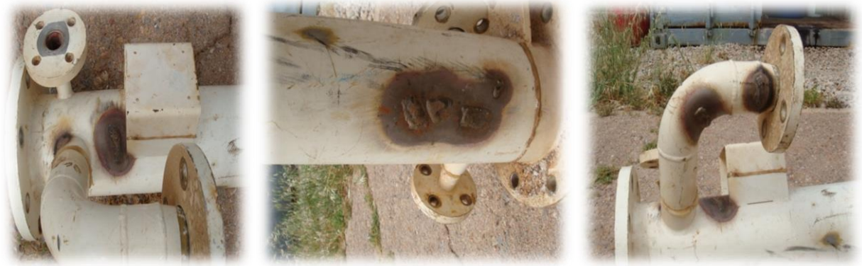
Fig IV.1 calandre du condenseur
