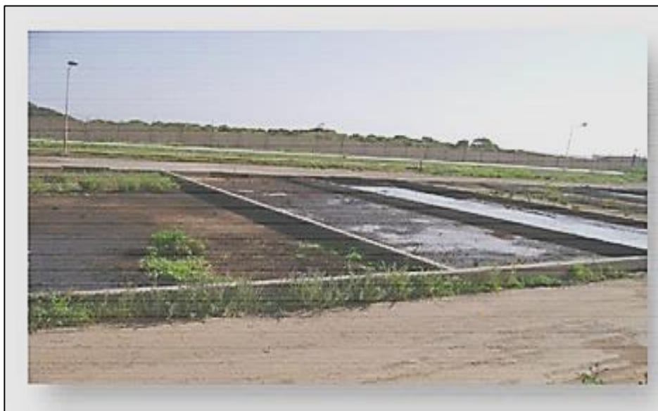
Figure II.7 : Drainage sur lit de sable.
