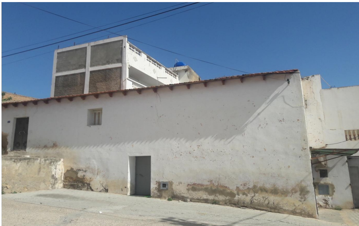
Habitation en bon état
