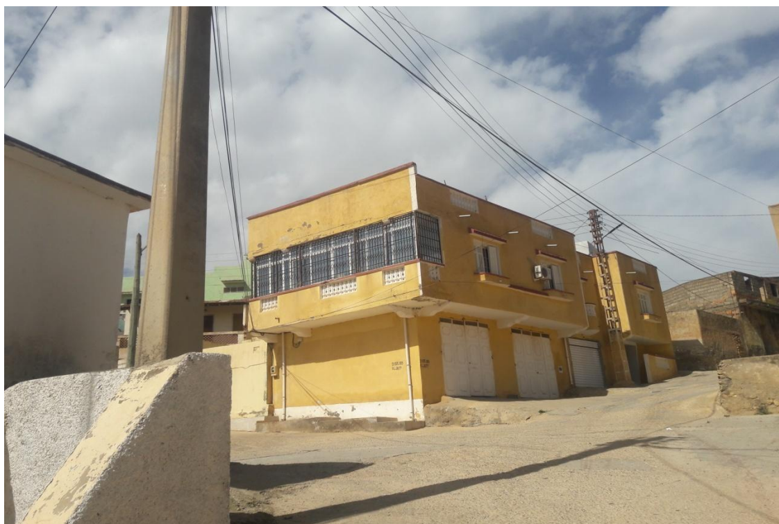
Habitation en bon état modification illicite sans permis de construire
