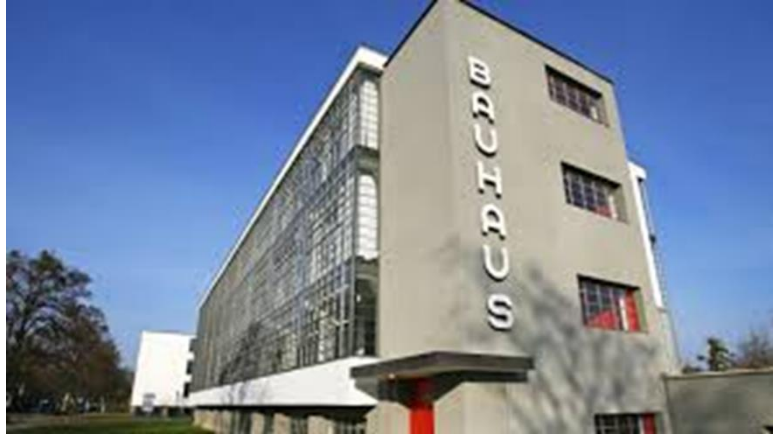
Figure 30: École Bauhaus - Allemagne
