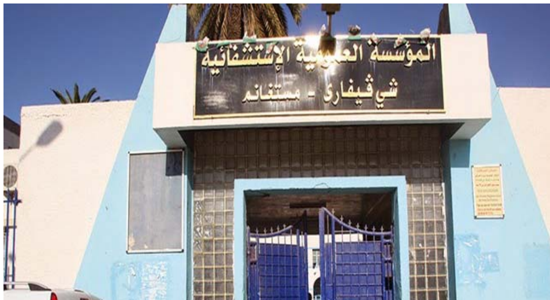
Figure 104 : Vue de la face de l'établissement public hospitalier -Chéguévara- Mostaganem.
