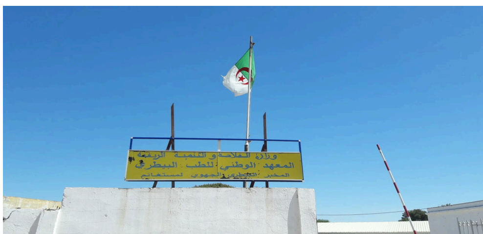
Figure 108 : Vue de la face du laboratoire vétérinaire régional de Mostaganem.
