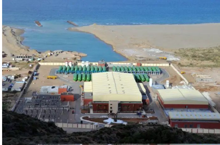
Figure 9: station de dessalement de l'eau de mer SONACTER [37]
