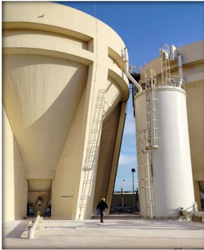
Figure 17: système de dosage de la chaux
