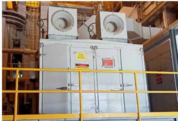
Figure III-10 : Huile de graissage de la turbine à gaz.
