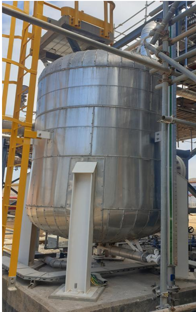
Figure II-1 : Réservoir d'expansion.
