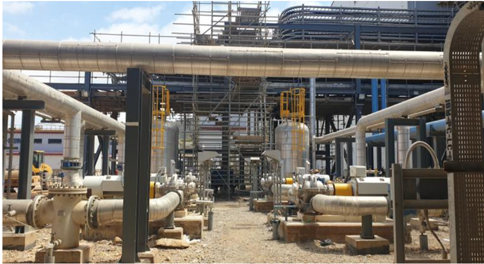
Figure III-3 : Le système de refroidissement en circuit fermé de la TG11 et TG12 à Samsung c&t.
