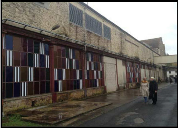
Vue sur façade extérieur du moulin
