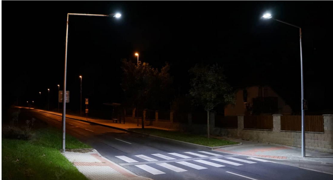
Figure I. 16 : Éclairage des zones piétonnes [15]
