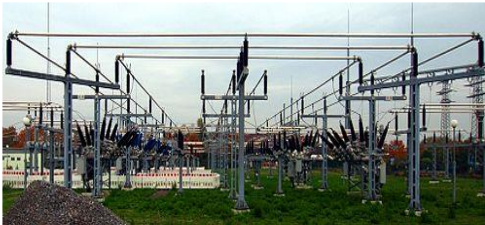
Figure (I.25) : tube conducteur
