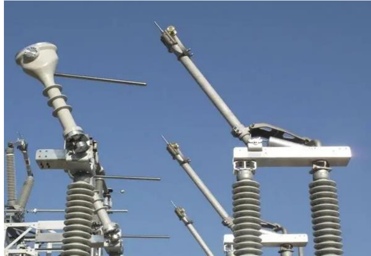
Figure (I.27) : Le sectionneur
