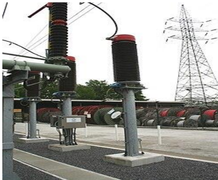
Figure (I.23) : transformateur de tension [12]
