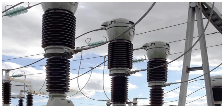
Figure (I.26) : Disjoncteur de poste HT [17]
