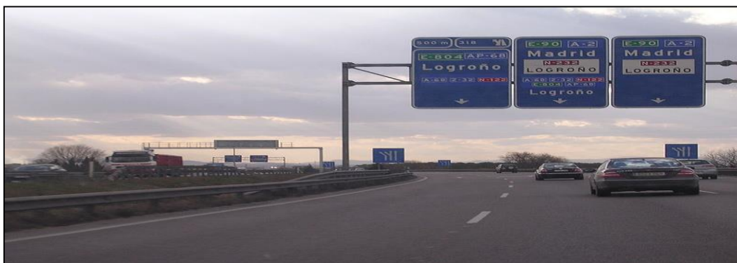
Figure n°5 : la rocade de Saragosse au niveau de la bifurcation avec l'AP-68.
