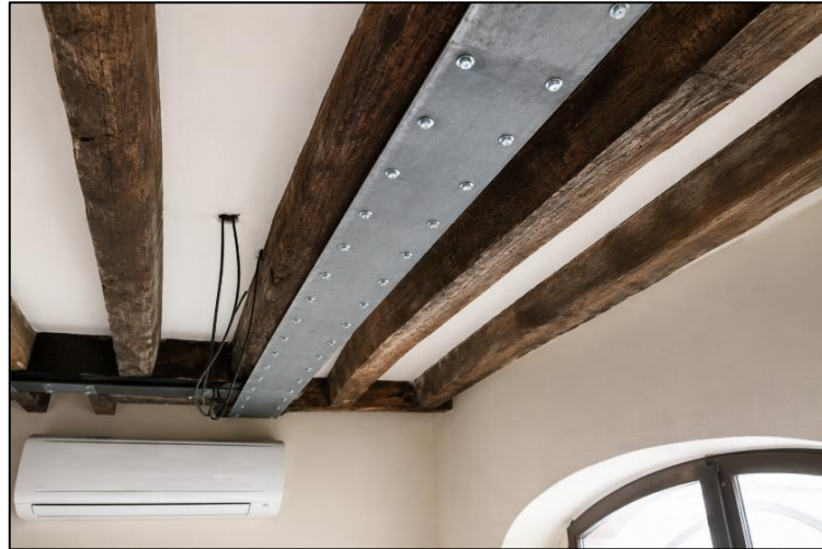
Figure I. 4. Réparation par boulonnage [3].
