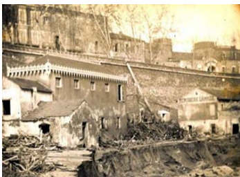
Figure 76: quartier matmore suit à l'inondation
