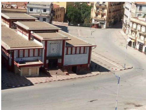
Figure 91: photo sur la place Gambetta coté marché couvert prise par l'auteur
