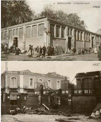
Figure 74 les dégâts causés par l'inondations près de la place Gambetta source :
