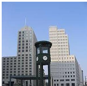
Figure 39: traitement de façades, source :
