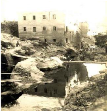
Figure 75: quartier Derb suit à l'inondation
