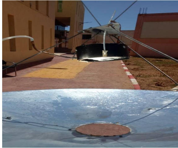
Figure 28 : Vue générale de l'installation complète
