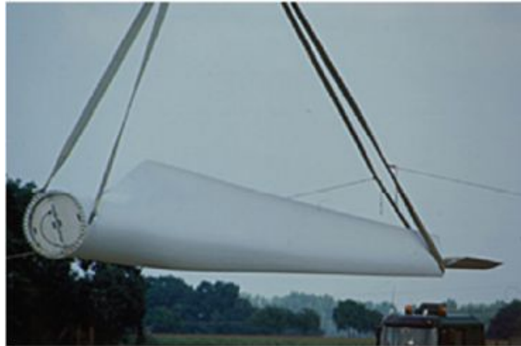
Figure I-11 : pales d'une éolienne avec système de freinage en bout
