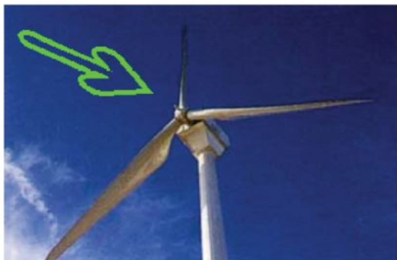
Figure I-10 : éolienne face au vent avec pylône cylindrique de grande section
