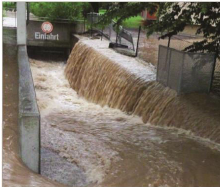
Figure 14: Inondation d'un parking souterrain. Source : Guide pour les projets de construction à l'intérieur des zones inondables.
