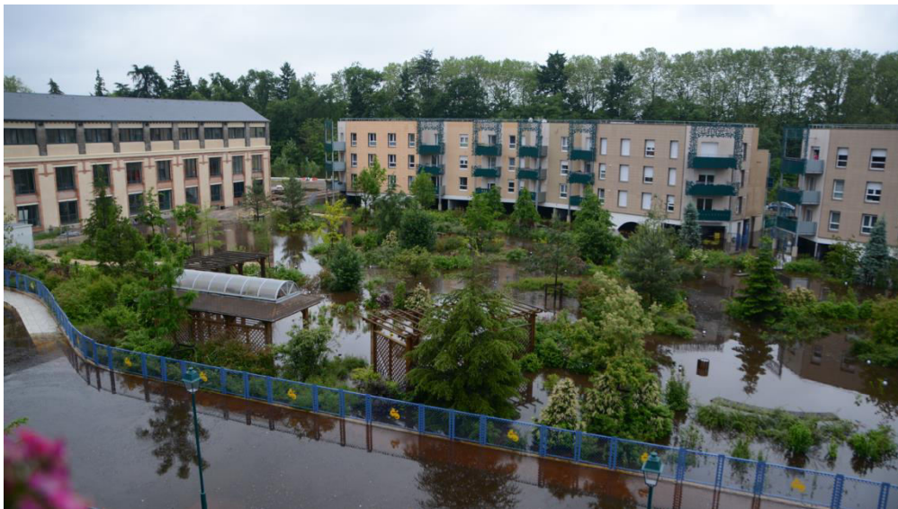
Figure 109 : Le jardin de Sologne, un bassin de rétention en période de crue. Source: https://carrefour.Vivre en Ville.org/publication/inondations-aménager-des-quartiers-résilients .
