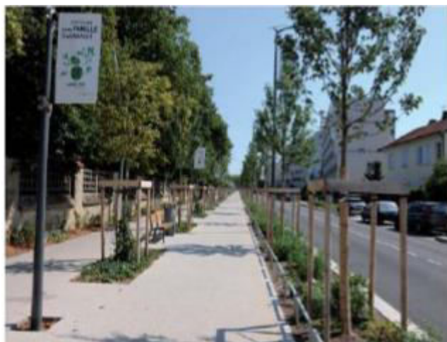
Figure 47 : Structure réservoir sous trottoir. Source : CHETTAH. S, Élaboration d'un protocole pour la gestion des eaux pluviales dans les projets d'aménagement, Mémoire de master, École Nationale du Génie de l'Eau et de l'Environnement de Strasbourg, 2011, disponible sur : https://dumas.ccsd.cnrs.fr/dumas-01661944
