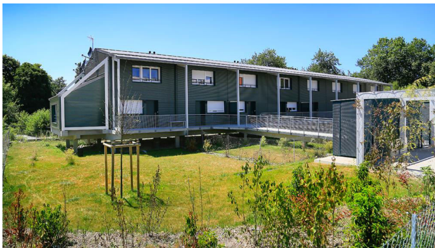
Figure106 : Maisons construites sur pilotis. Source: https://carrefour.Vivre en Ville.org/publication/inondations-aménager-des-quartiers-résilients .
