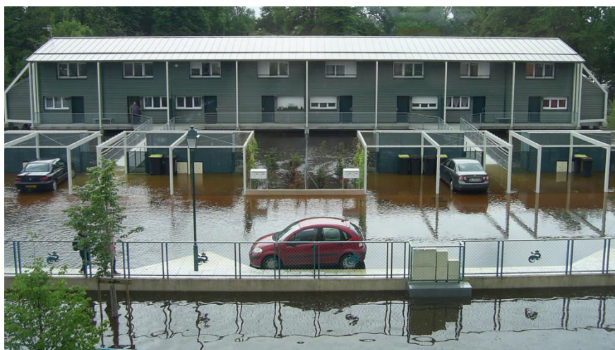
Figure 107: Maisons sur pilotis épargnées lors de la crue de 2016. Source: https://carrefour.Vivre en Ville.org/publication/inondations-aménager-des-quartiers-résilients .
