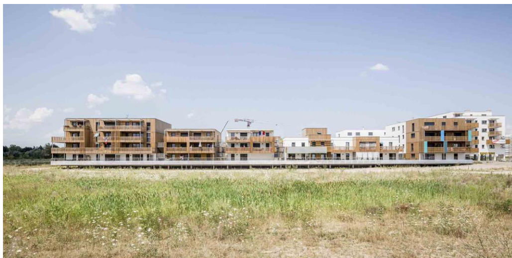
Figure115 : Ensemble d'habitations élevé sur une plateforme au-dessus d'une prairie. Source: https://carrefour.vivreenville.org/publication/inondations-aménager-des-quartiers-résilients .
