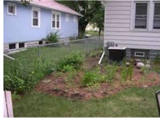
Figure 52: Jardin de pluie en descente de gouttière Richemond, Province du Québec.
