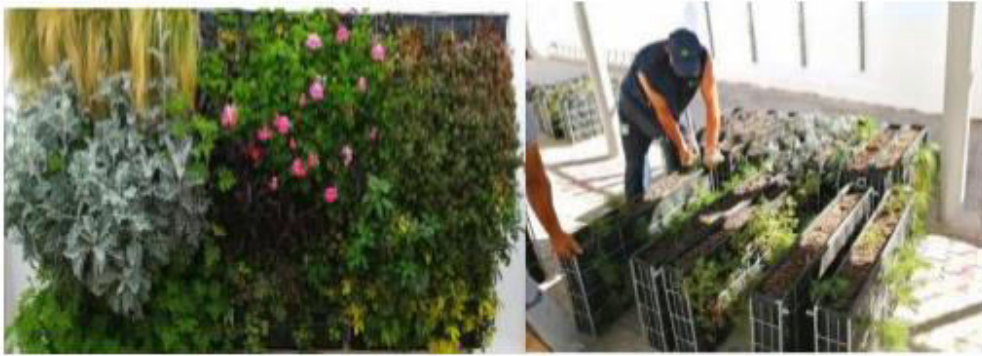
Figure 72: Mise en place des murs végétalisés dans l'école Robert Desnos Tunis, conçu et réalisé par la société SICAP. (Eco Végétal). Source : BOUDIAF. S, Gestion des eaux pluviales et développement durable : Cas de la région d'Aïn Temouchent, Mémoire de master, Université de Temouchent, 2024, disponible sur : https://dspace.univ-temouchent.edu.dz/handle/123456789/4920
