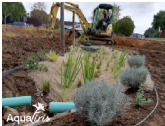
Figure 55 : Jardin de pluie en cours de création ©Aquatirais
