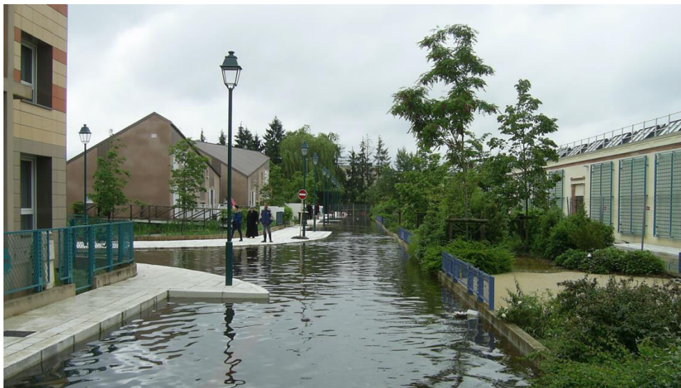
Figure 105: Trottoirs surélevés accessibles malgré la crue de 2016. Source: https://carrefour.vivreenville.org/publication/inondations-aménager-des-quartiers-résilients .
