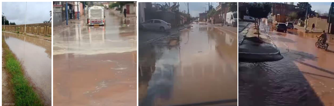
Figure 134: Schéma des voies existantes. Source : auteur, les photos de site. Source : auteur ; page facebook : vallée des jardins.
