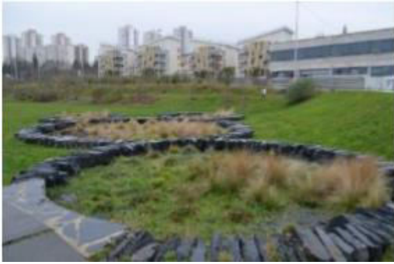
Figure 51: Jardin de pluie récupérant l'eau des voiries Noisy-le-Sec (Parc des Guillaumes) ©Urban Water – Christian Piel
