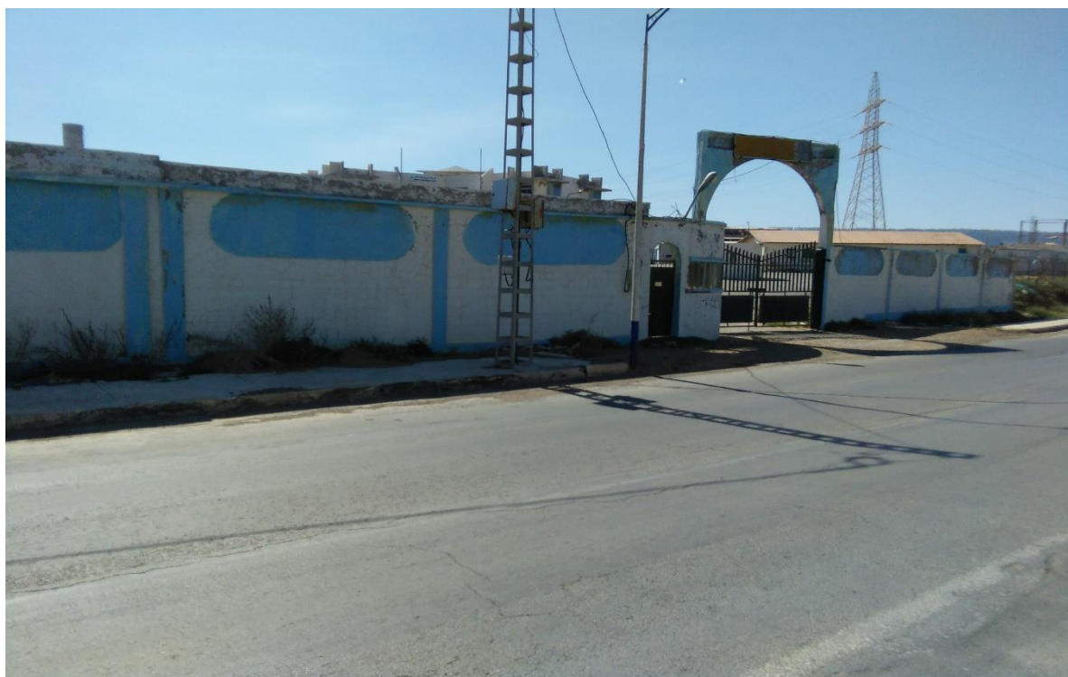
Figure 52: photo de constat, soachlore, auteur 03/05/2017.
