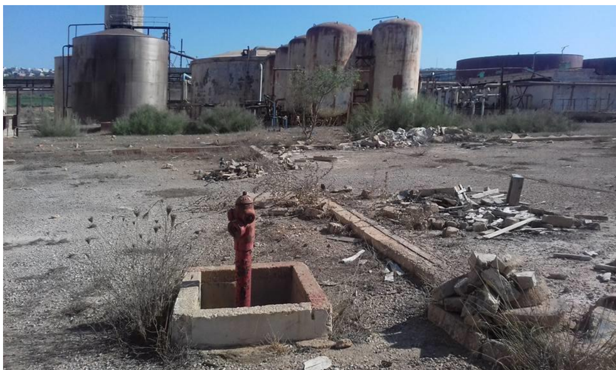
Figure 48 : Photo de constat, l'état actuelle de l'usine a l'intérieur, auteur 18/04/2017.
