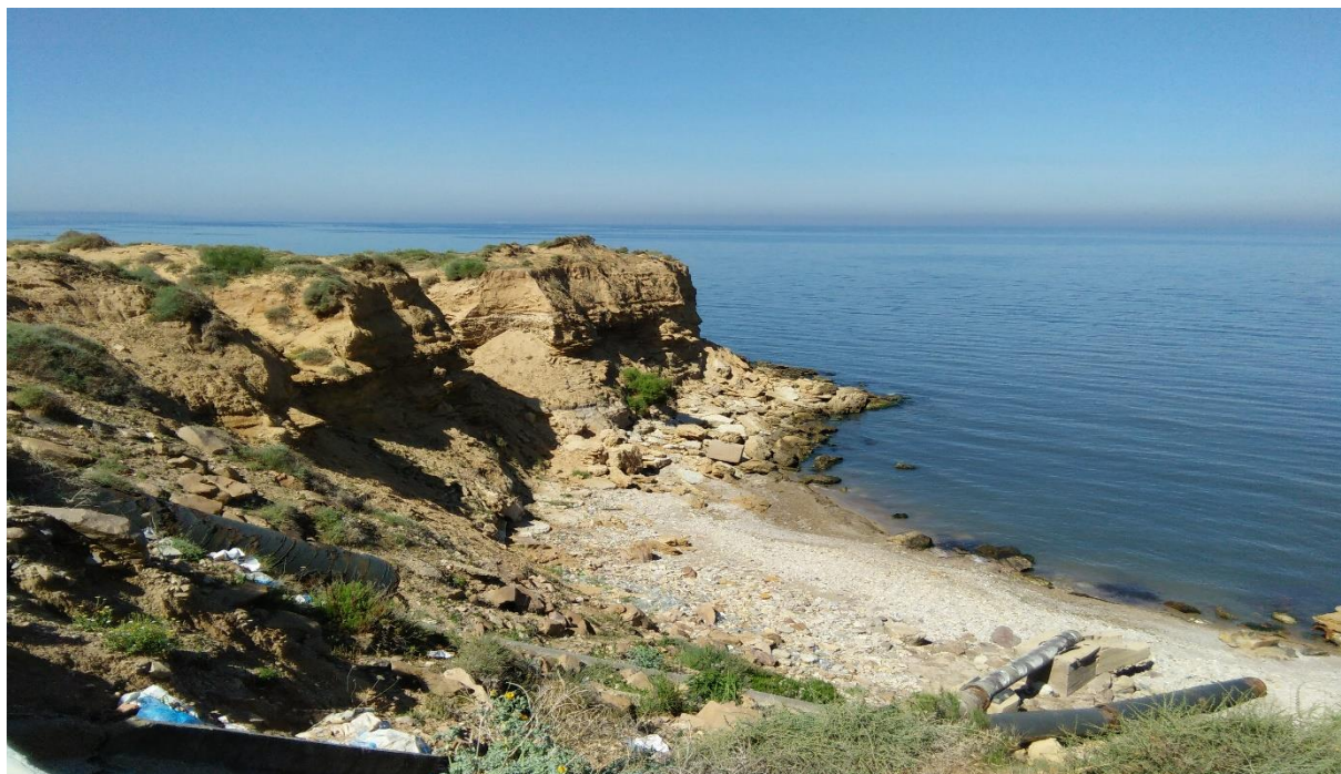
Figure 53: photo de constat, état dégradé de la falaise crique, auteur 03/05/2017.
