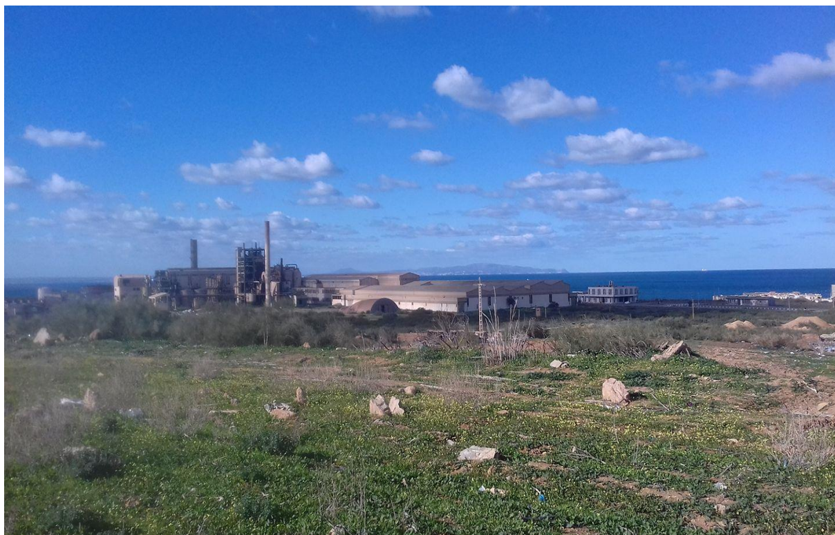
Figure 46 : Photo de constat, vue d'ensemble de l'usine, auteur 18/04/2017.
