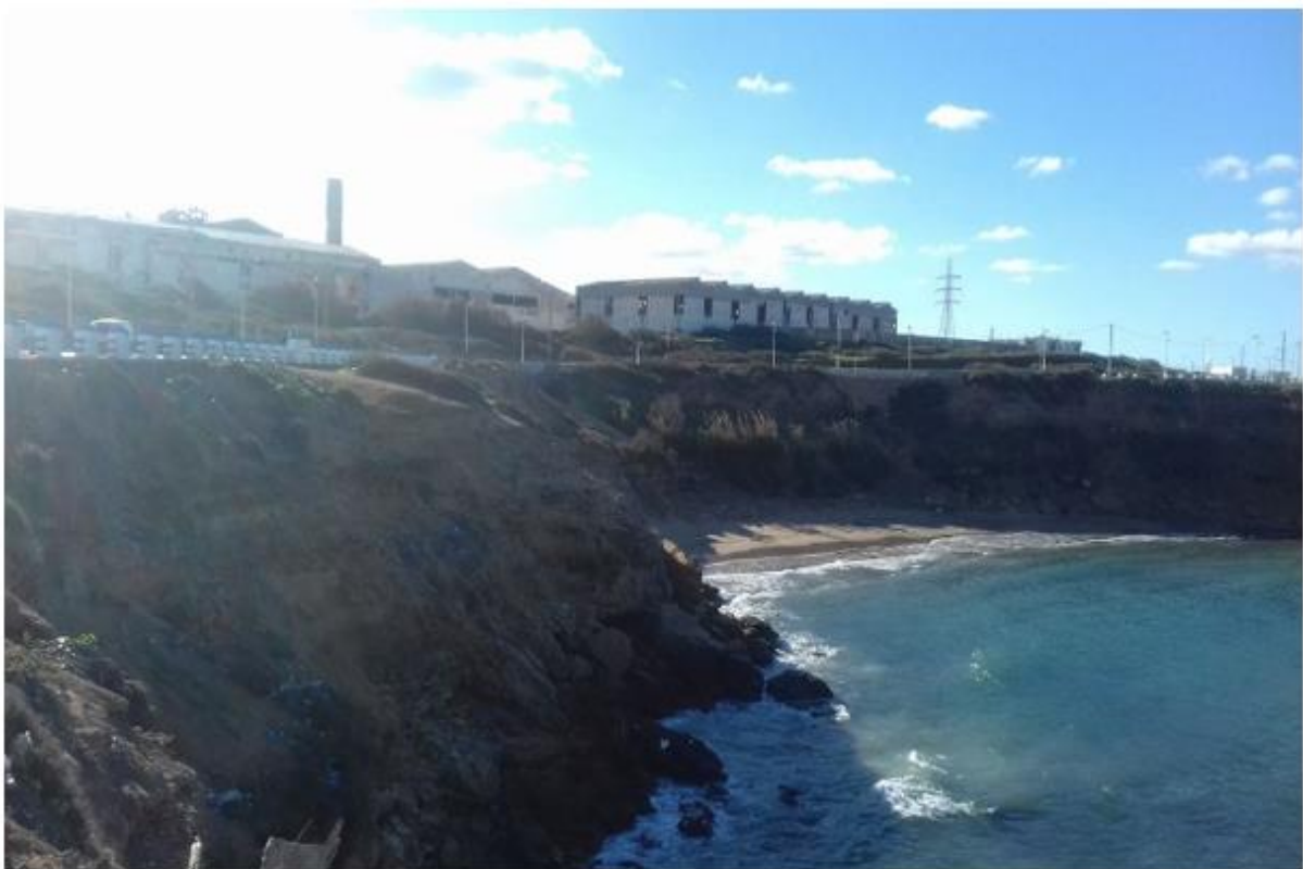
Figure 44 : Photo de constat, la plage de la crique, auteur 18/04/2017.
