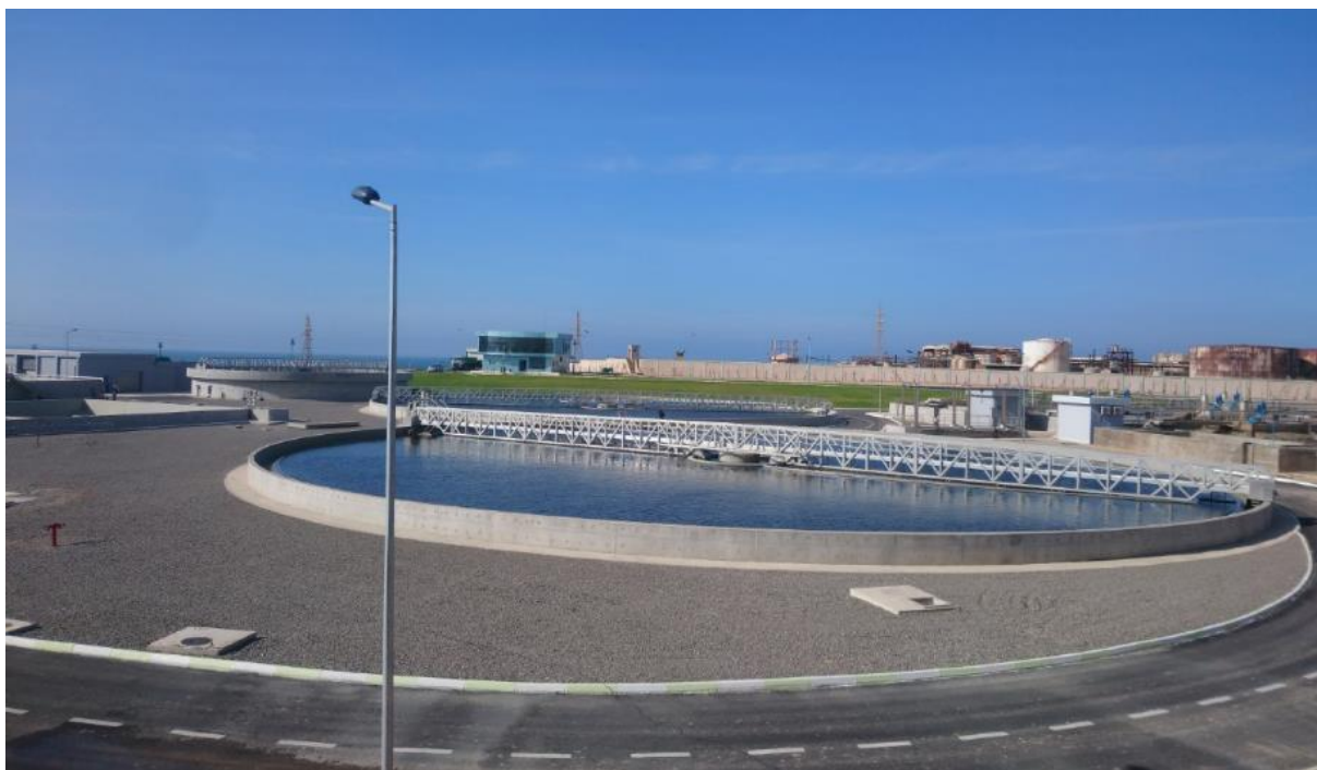
Figure 51 : Photo de constat, bassin de la nouvelle station d'épuration, auteur 19/02/2017.
