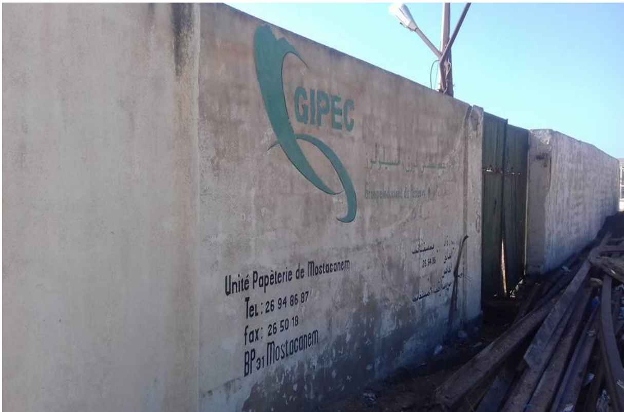
Figure 43 : Photo de constat, l'entrée de l'usine GIPEC, auteur 18/04/2017.
