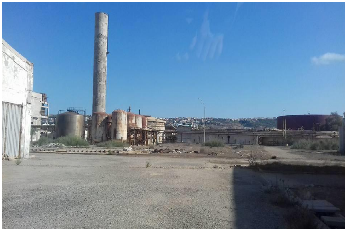
Figure 45 : Photo de constat, le château d'eau de l'usine, auteur 18/04/2017.
