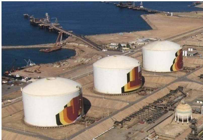
Figure I.7 : Bacs de stockage de gaz naturel liquéfié. [7]
