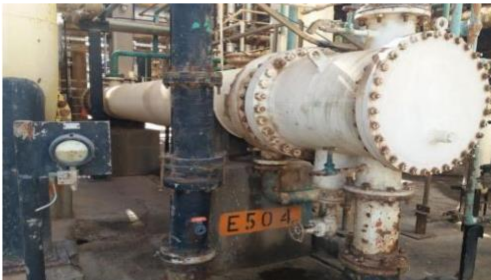
Figure II.6 : Echangeur E504 de la section de décarbonatation.
