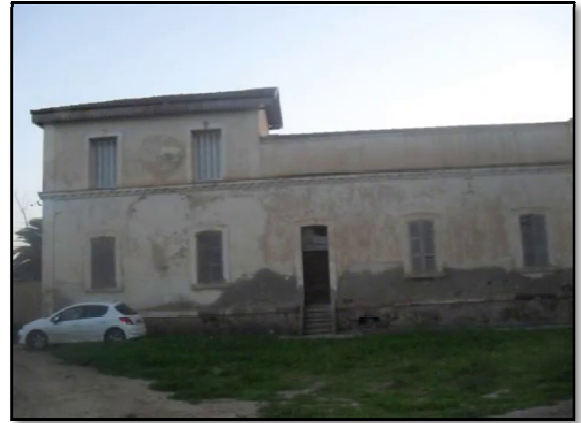
Figure 05 : vue générale vers le bâti - moyen état-
