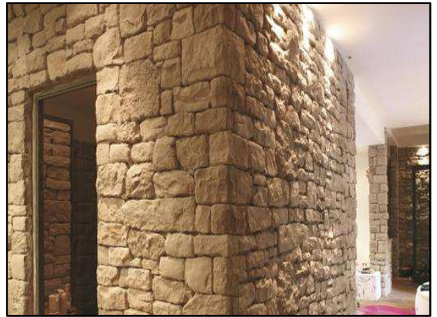
Figure 104: photo représente le matériau utilisé dans la construction - pierre -
