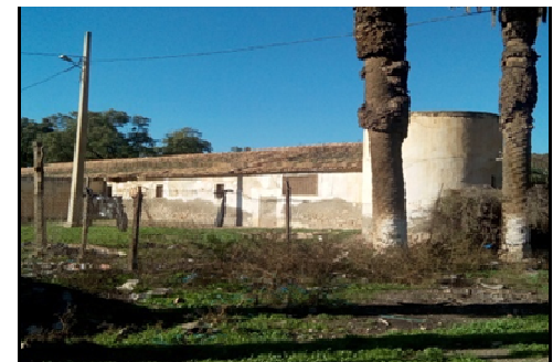
Figure 41: Vue générale vers l'hangar
