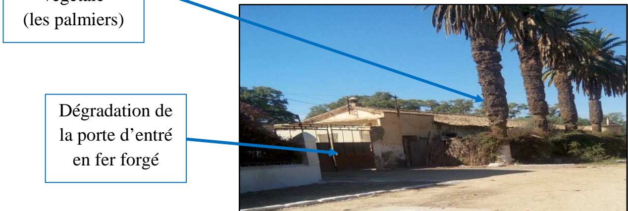
Figure 51: Vue générale représentative de l'entrée principale de l'hangar
