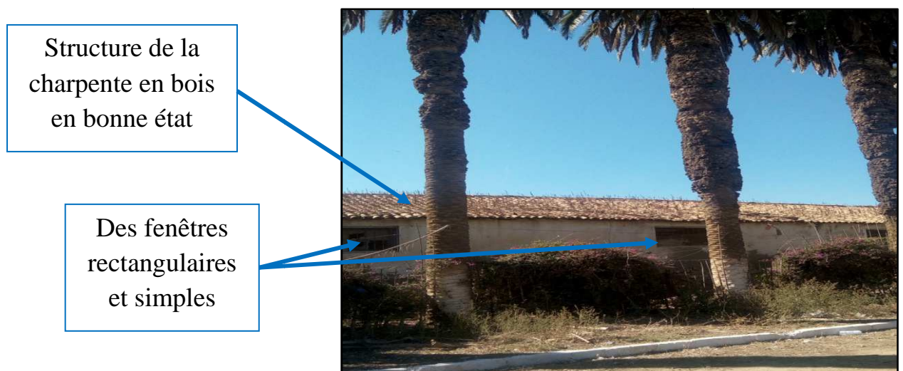
Figure 52: Vue générale représentative de la façade EST de l'hangar
