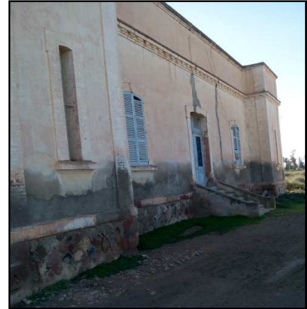
Figure 46: vue générale vers le bâti - moyen état-
