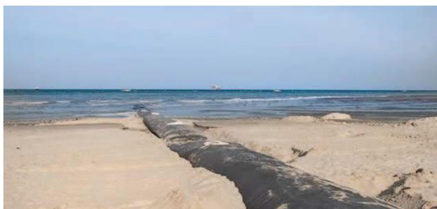
Figure 29 Epi en géotextile (source : http://www.novintiss.com/fr/geotextile-anti-erosion.html ) (CHAIB W. 2021)
