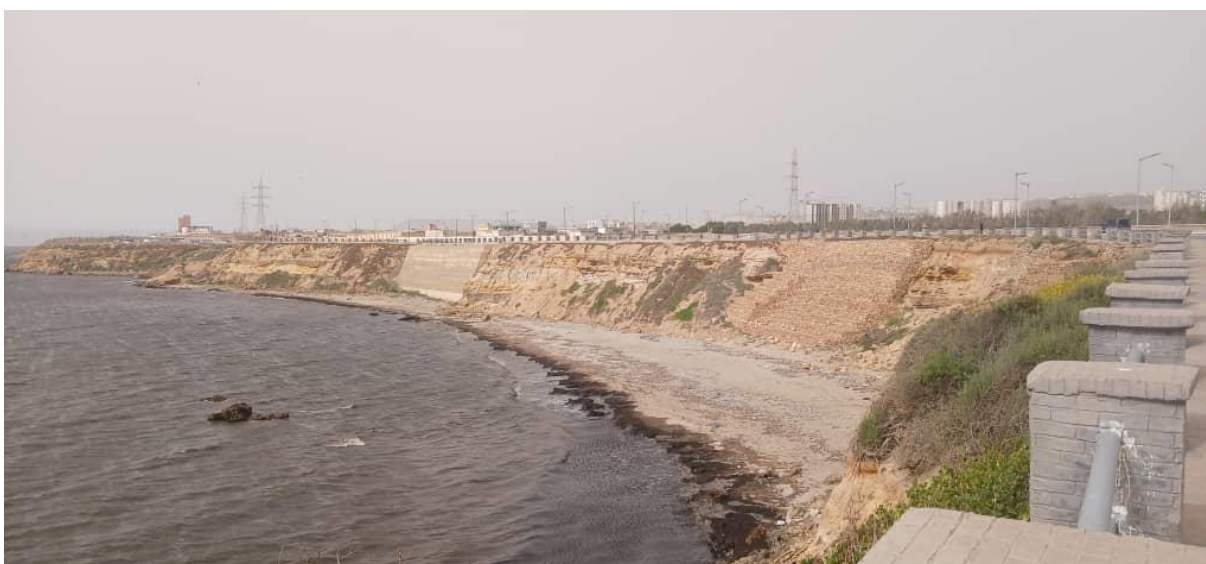
Photographie 2 Plage Sablette, Protégé par la technique d'enrochements pour limiter l'érosion du trait de cote
