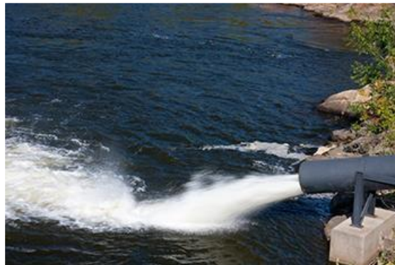
Figure I.6 Rejet de saumure dans la mer
