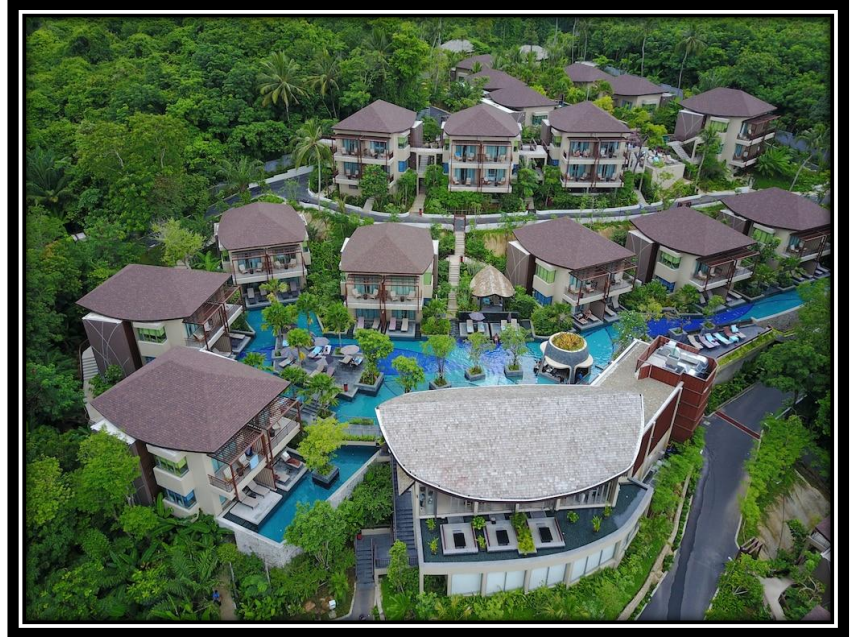
vue sur l'ensemble du projet
