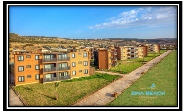
construction en bois avec panneaux solaire photovoltaïque en toiture
