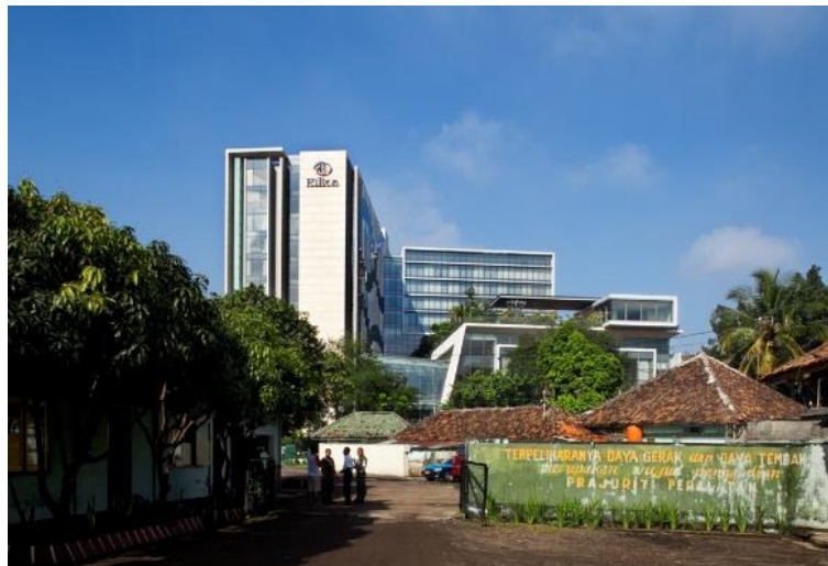
Figure 44. Vue sur Bandung Hilton hôtel (Source : https://www.archdaily.com )
