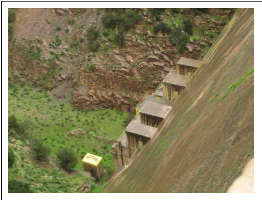
Figure I.24 : Vannettes de dévasement du barrage de l'oued El Fodda (Cliché de Remini – 2006)
