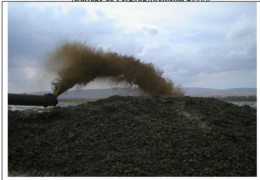
Figure I.9: Ecoulement de la vase à sa sortie d'une vidange de fond. (Barrage de Fergoug)[Semcha, 2006].
