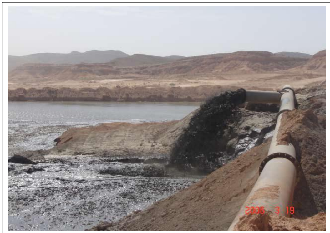
Figure I.19 : Évacuation de 4 Mm 3 de vase de la retenue de Foum El Gherza pendant 18 mois (Cliché de l'Agence Nationale des Barrages de Biskra – 2006)
