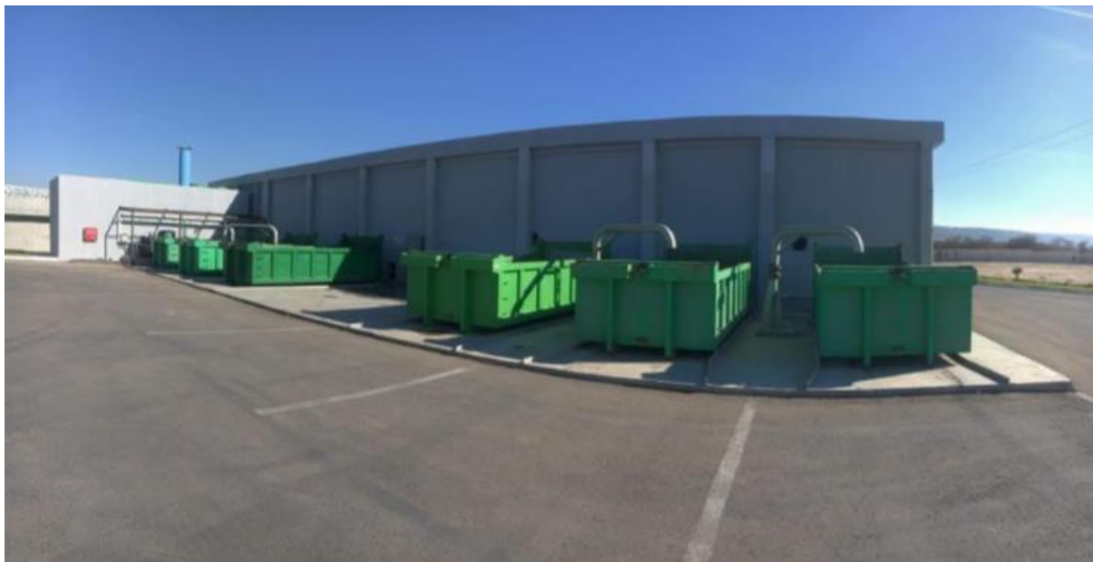
Figure II.14: Stockage de boues déshydratées
