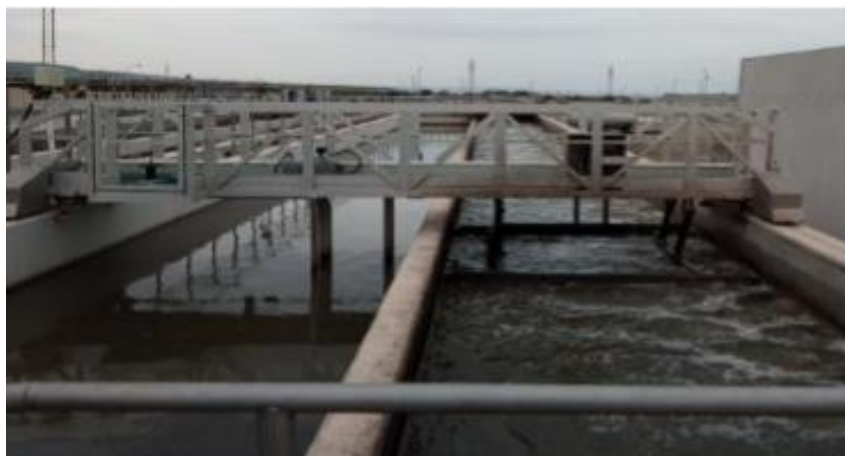
Figure II.6: Dessablage — Déshuilage
