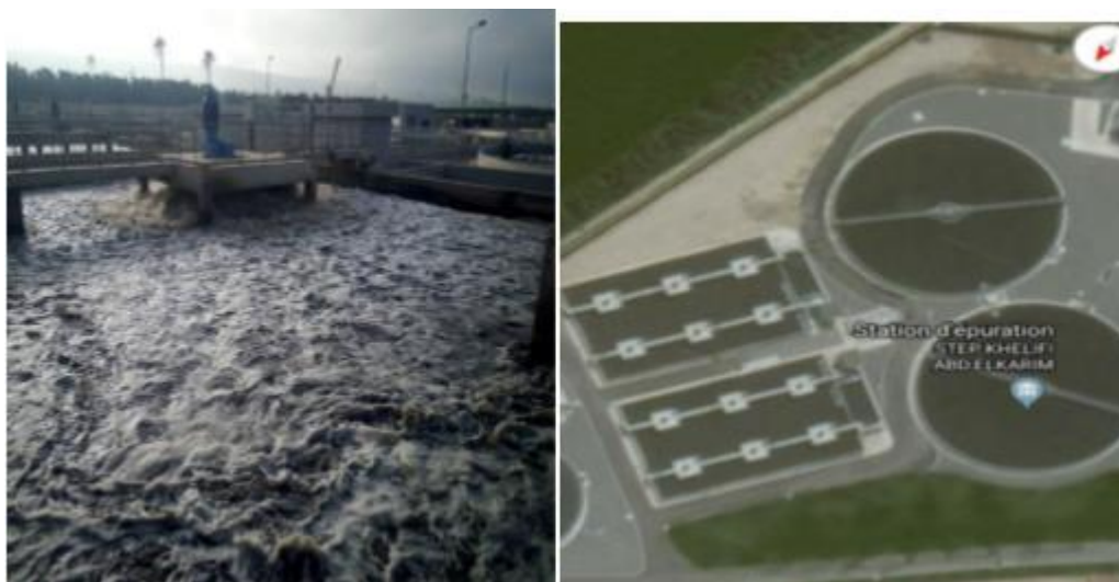
Figure II.8: Bassin biologique (Bassin d'aération)
