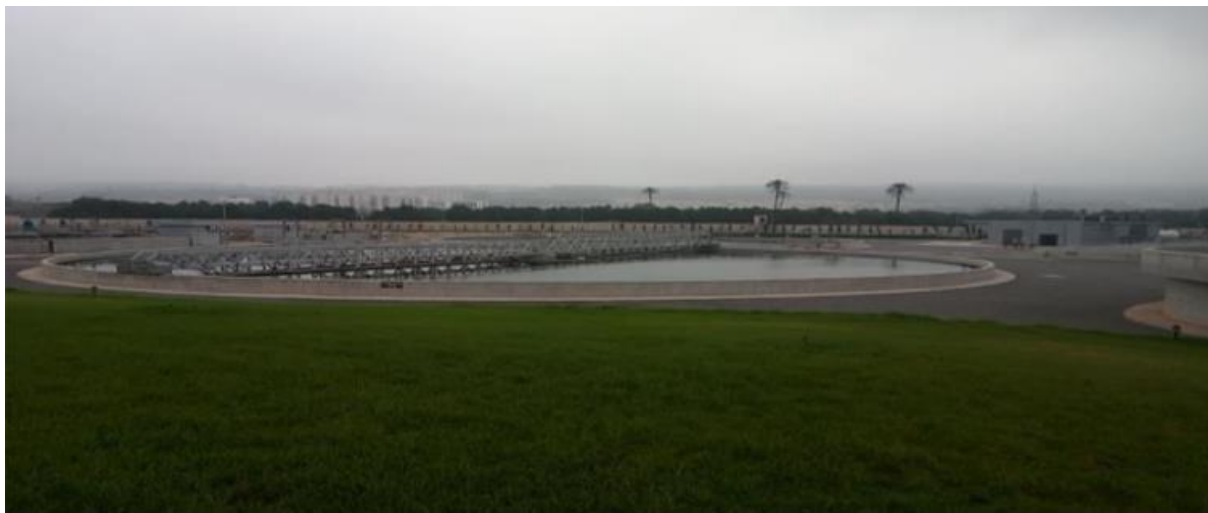
Figure II.9: Décanteur secondaire (clarificateur)
