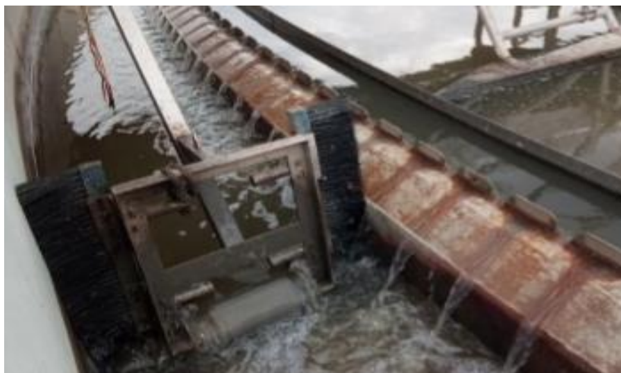
Figure II .7: Décanteur primaire
