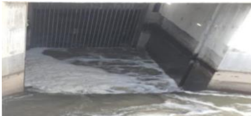
Figure II.4 : Dégrilleur grossier
