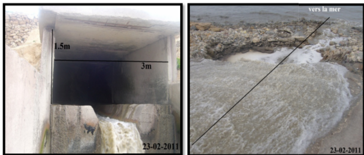
Figure III-15 : présentation du débit du rejet N°03. (T.M ; 2011).
