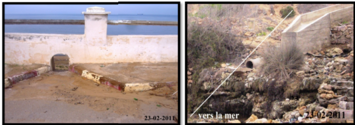
Figure III-16 : présentation du rejet des eaux de ruissèlements N°04. (photo : T.A ; 2011).
