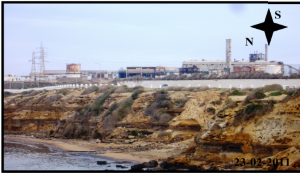
Figure III-11 : complexe « Sonic ». (photo : T.A ; 2011).
