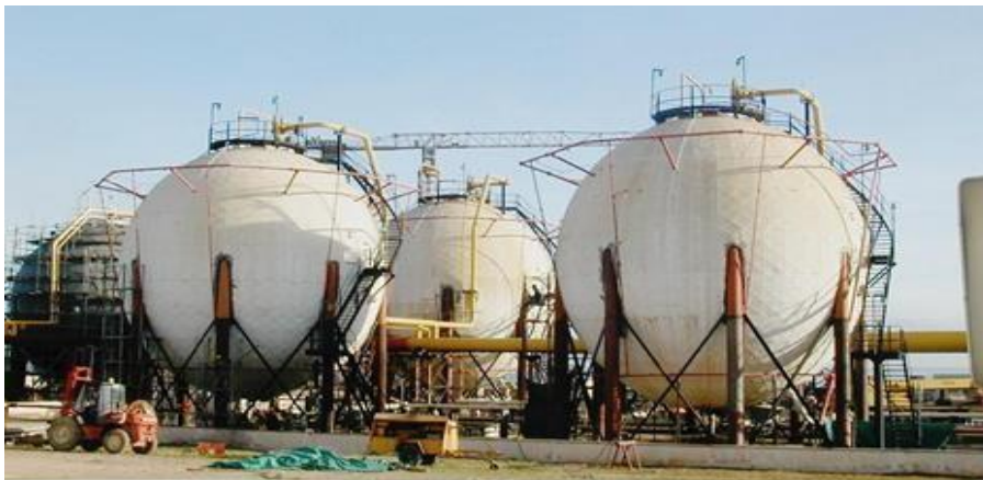
Figure I.8 : Sphères de stockage
