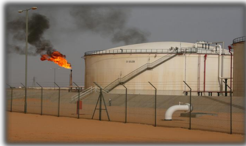
Figure II.4 : Torchère d'une installation pétrolière.
