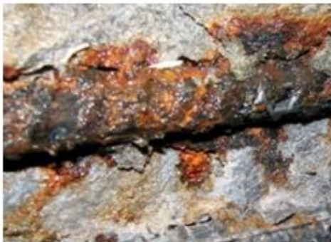
Figure I.4 : Dégradation due à la corrosion des armatures [20]
