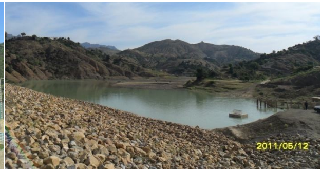
Photo. 4.2- Le petit barrage de Tamellahet.
