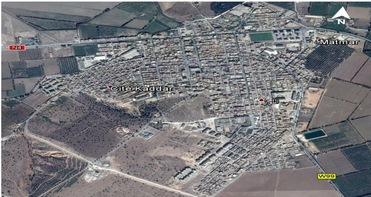
figure n°23 :l'habitat Groupé (l'ACL d'ElMatmar) (Google Earth)
