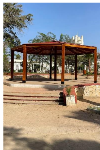
Figure 78: Kiosque en bois, Source : Auteurs.
