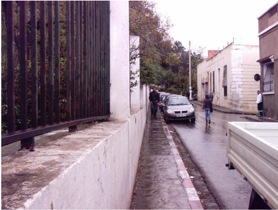
CLOTURE COTE RUE SEGHIAR HACHEMI A REVALORISER EN LA REMPLACANT PAR UNE CLOTURE DECORATIVE . Bekkadra.tadmout.2015
