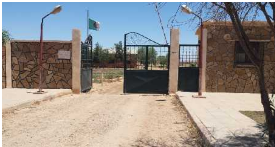
Figure N°06 : l'entrée d'ITELV de ksar chellala
