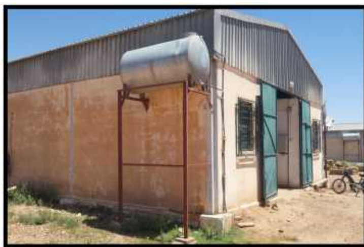
Figure N°15: l'installation des conduites de l'eau dans les bergeries des ovins
