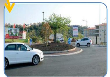
Création d'un rond-point au cimetière Alphonse Karr
