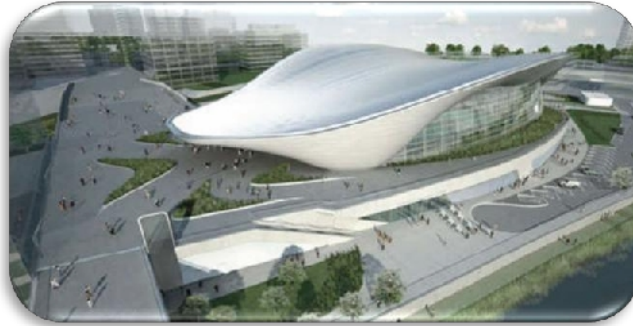
Vue générale sur la piscine
